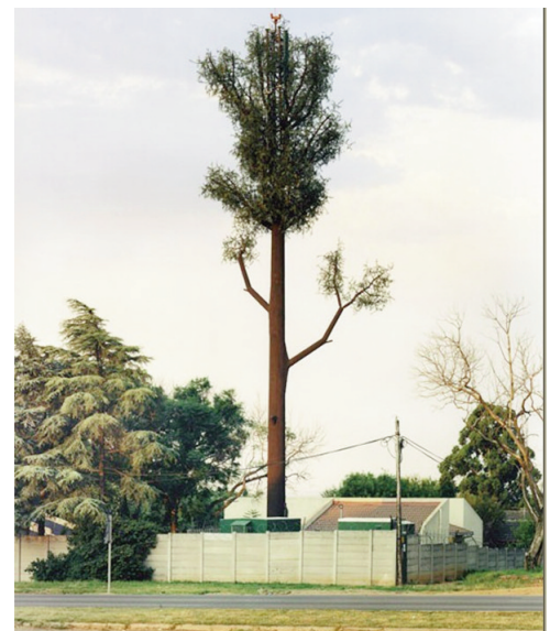
Antenne relais de téléphone mobile subtilement déguisée
