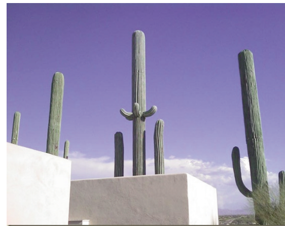
Antenne relais de téléphone mobile «totale-ment» déguisée
