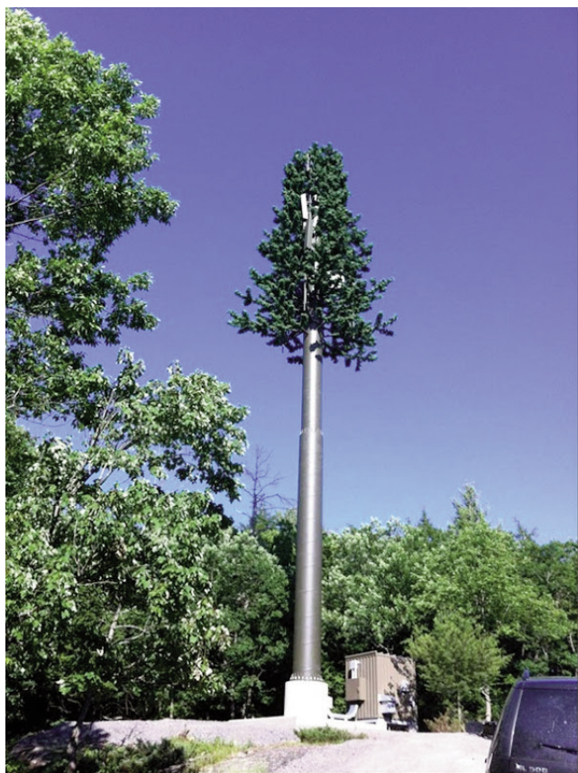
Antenne relais de téléphone mobile partiellement déguisée
